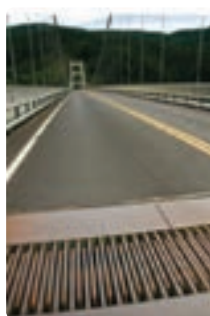
(ب) نمونه‌ای از بست‌های انبساطی
