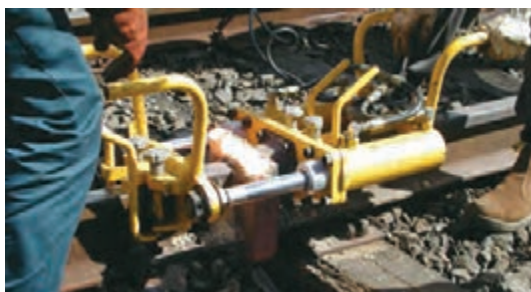
شکل ۲۴- برش گرده اضافی جوش
