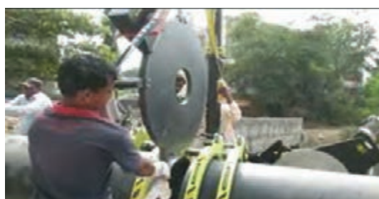
شکل ۱۸- جوشکاری لب به لب Butt Fusion
