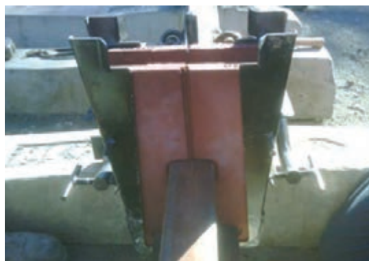
شکل ۱۸- نصب قالب اطراف ناحیه اتصال
