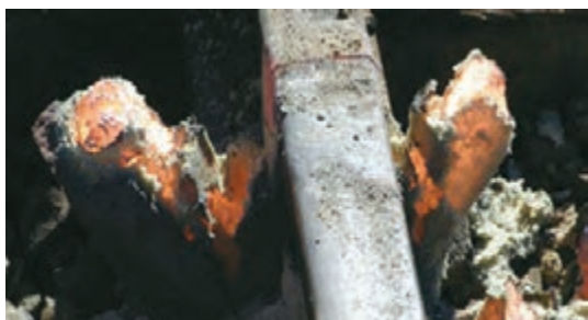
شکل ۲۴- برش گرده اضافی جوش
