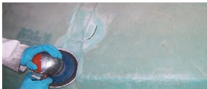
شکل ۲۶- آماده‌سازی سطوح پلاستیکی قبل از جوشکاری
