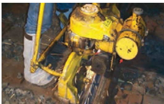
شکل ۲۵- سنگ زنی و پرداخت کاری سطح گرده
