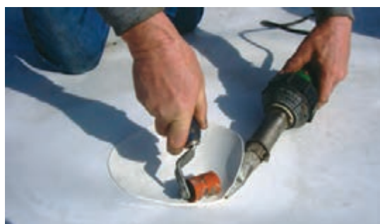
شکل ۱۱- جوشکاری با گاز داغ به صورت دستی
