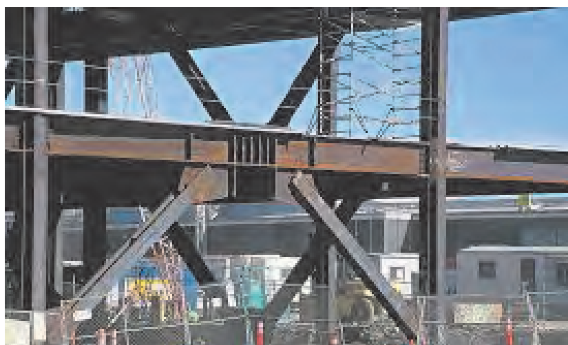
شکل ۲۷ ▲ مهاربند دوزنقه‌ای
