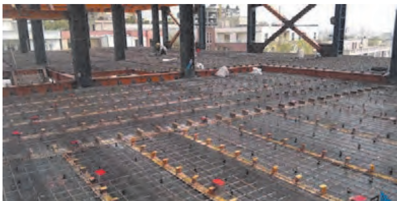
شکل ۳۲ ▲ سقف مرکب به همراه برشگیرها
