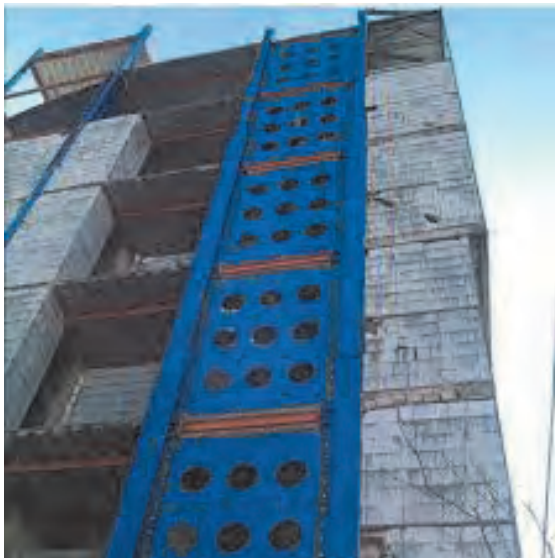
شکل ۶۱ ▲ دیوار برشی فولادی
