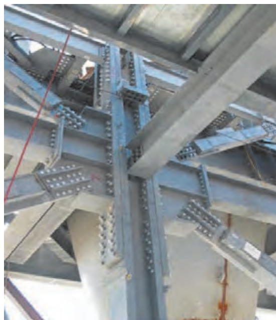
شکل ۵۱ ▲ اتصال مهاربندی
