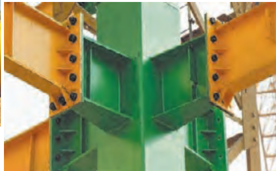
شکل ۵۰ ▲ انواع اتصال فلنجی
