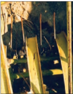
شکل ۹- پایه انگشتی شکسته
