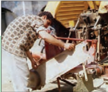
شکل ۱۵- پیاده کردن حفاظ
