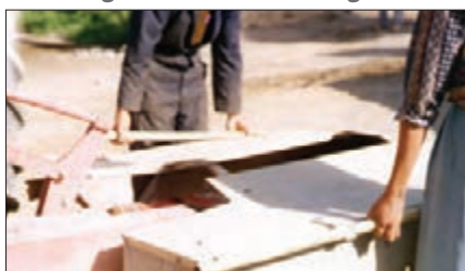
شکل ۶- پیاده کردن حفاظ
