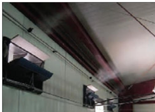
شکل ۲- نحوه خنک شدن هوا توسط سیستم نازل مه پاش
