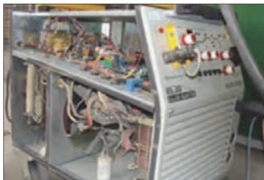
شکل ۱۱- ساختمان داخلی رکتیفایر
