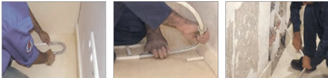
استفاده از فنر برای خم کردن لوله
