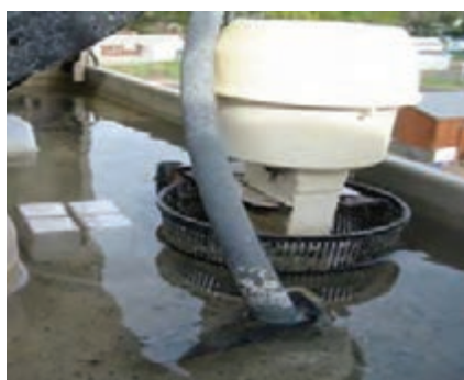
شیلنگ رابط پمپ و چهارراهی
