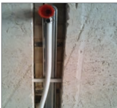
اتصال لوله به دیوار
