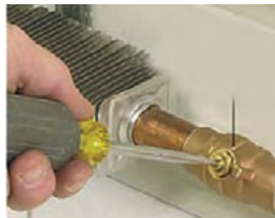
شیر هواگیری کنوکتور
