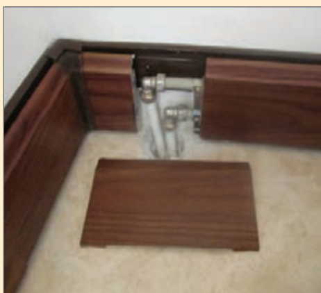
اتصال لوله‌کشی رادیاتور قرنیزی با کاور نهایی
