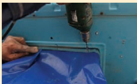
اتصال کانال توزیع هوا به دهانه کولر
