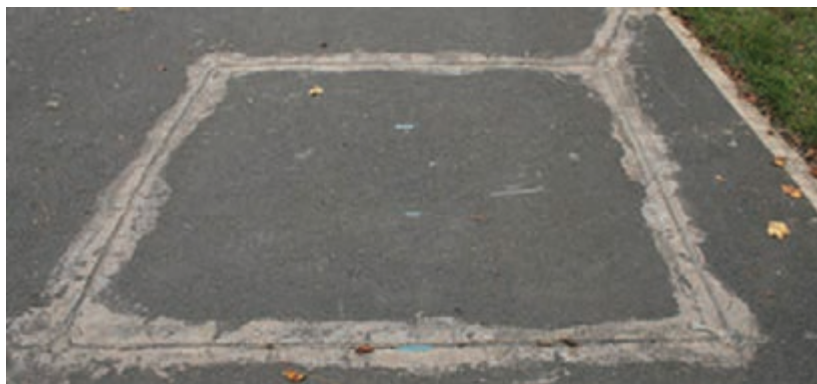
شکل ۲- نمونه نصب شده از حلقه‌های مغناطیسی
