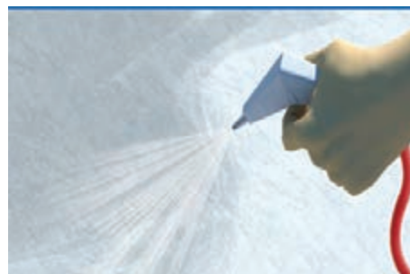
پاشیدن مواد نگهدارنده رطوبت بر سطح بتن
