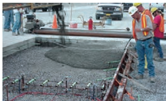
اجرای روسازی بتنی با استفاده از قالب‌بندی
