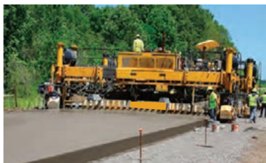
اجرای روسازی بتنی با استفاده از دستگاه
