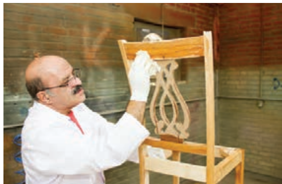
شکل ۱۴۶- زدن سیلر با کهنه رنگ‌کاری
