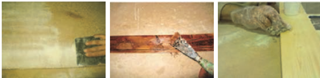
شکل ۵۴- آب زدن به بتونه هم‌رنگی شکل ۵۵- یک تخته آستری خورده شکل ۵۶- استفاده از بتونه رقیق در مرحله اول
