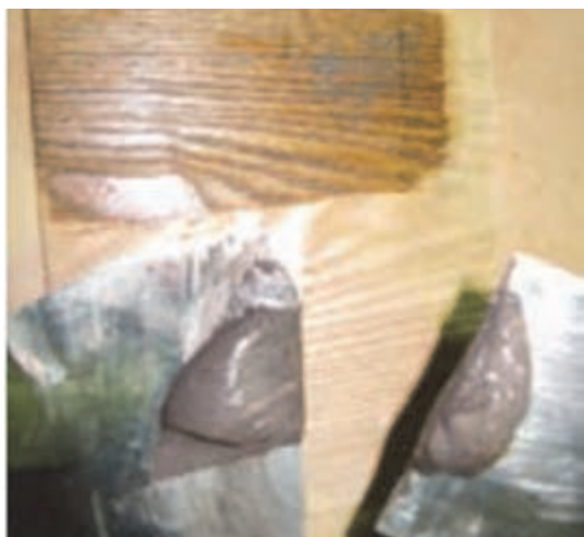
شکل ۱۳۸- برداشتن بتونه
