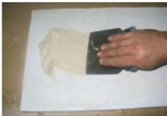
شکل ۹۱- ساخت بتونه سریشی
