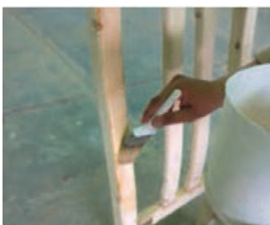
شکل ۹- زدن آب روی کار قبل از آستری زدن
