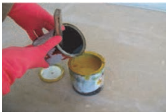
شکل ۸۵- اضافه کردن روغن جلا به رنگ روغنی
