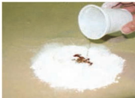
شکل ۷۸- اضافه نمودن آب به بتونه روغنی
