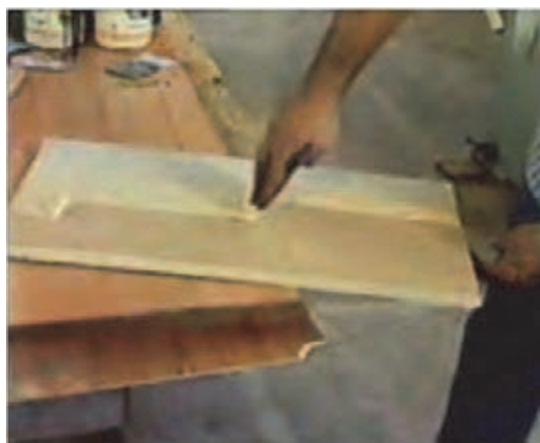
شکل ۱۳- ماستیک زدن
