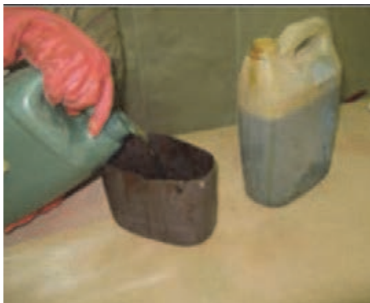
شکل ۴- رقیق کردن روغن الیف با تینر روغنی
