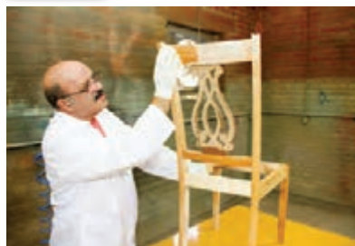
شکل ۵۹- زدن روغن بزرک با کهنه
