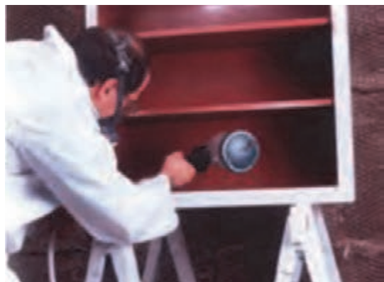
شکل ۲۳- رنگ کاری قسمت های داخلی
