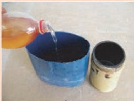
شکل ۷- رقیق کردن آستری قیری با بنزین
