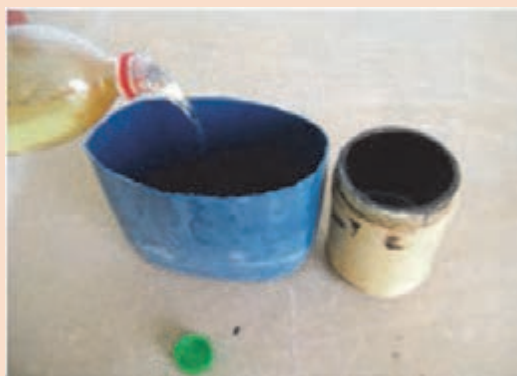
شکل ۸- اضافه کردن نفت به آستری قیری
