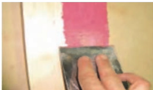
شکل ۹۲- ماستیک کاری با بتونه روغن رنگ قرمز
