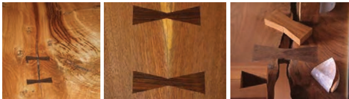
شکل ۳۵- نمونه‌هایی از سازه‌های پهن و گسترده، که در آن اعضاها با زبانه‌های پروانه‌ای یا دم چلچله به صورت طولی به هم متصل شده‌اند.
