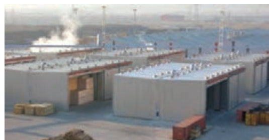
شکل ۲۹- کوره‌های چوب خشک‌کنی ساخته شده با آلومینیوم
