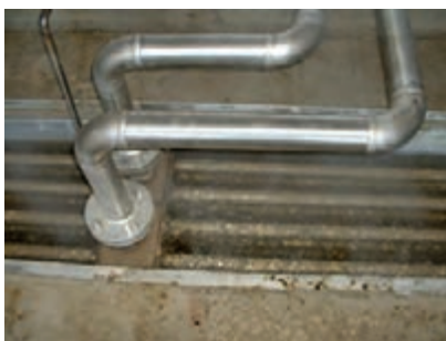
شکل ۶۱- کویل‌های حرارتی برای گرم کردن هوای کوره
