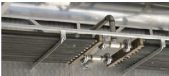
شکل ۴۱- انتقال حرارت کویل‌ها با هوای اطراف خود
