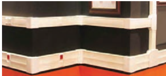
شکل ۵۳ - محل تقاطع ترانک‌ها و داکت‌ها
