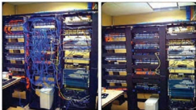
شکل ۴۱- مرتب کردن کابل‌ها
