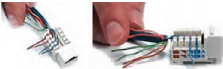
شکل ۳۲- قرار دادن سیم‌های کابل در کیستون
