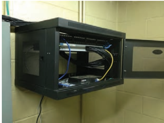
شکل ۴-۱۴ - نمونه‌ای از رک دیواری
