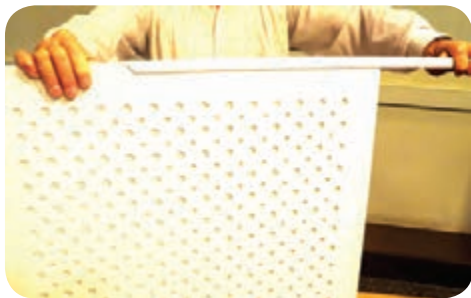
شکل ۲-۱۰- نصب قاب روی تابلو
