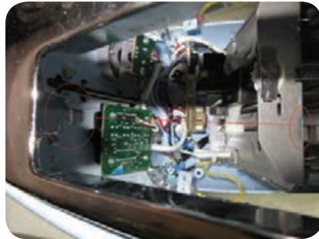
شکل ۶-۵۷ محل اتصال قسمت‌های فلزی
