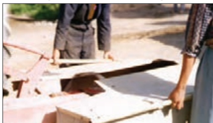
شکل ۶- پیاده کردن حفاظ
