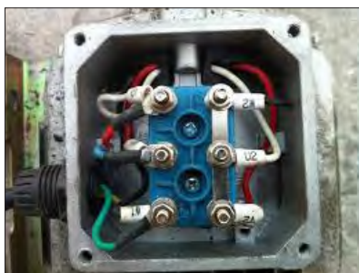
شکل ۳- پلاک اتصالات موتور الکتریکی
