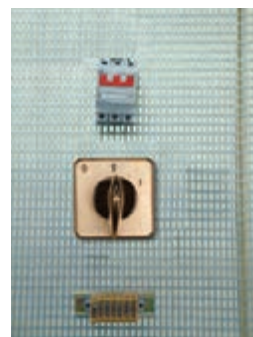
شکل ۱۳۵ - نمای قطعات نصب شده روی تابلو
