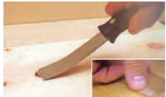
شکل ۴-۱۷- فقط باید ترک‌ها، زدگی‌ها و... را بتونه کشید.
