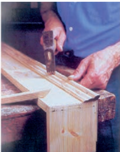
شکل ۱۳-۱۰- نصب زهوار با میخ.
