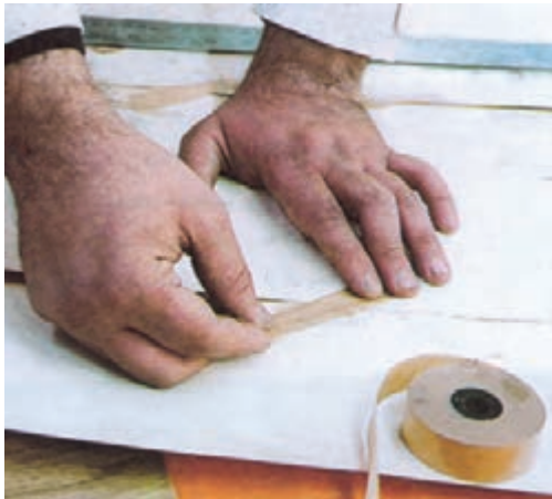
شکل ۵-۳۱- مراحل چسباندن روکش، با چسب کاغذی مخصوص (روکش).
