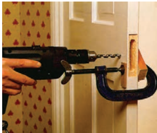
شکل ۱۰-۴۸- سوراخ‌کاری محل پلاک و دستگیره‌ی قفل.
