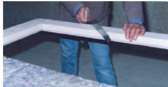
شکل ۱۱-۲۶- ایجاد شیار با اراهی دستی.
