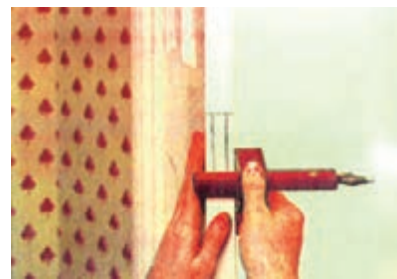
شکل ۱۰-۴۳- فلکشی ممل قفل با فلکشی تیره‌دار.
