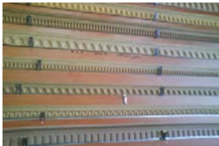
شکل ۲-۱۰- نمونه‌هایی از زهوارهای تزئینی؛ مورد استفاده در قرنیز، دیوارسازی و...
