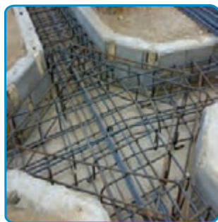
شکل ۱۴-۷- تکمیل میلگردگذاری محل اتصال ستون
