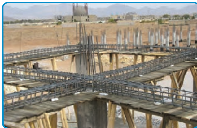
شکل ۷-۲۷- رعایت فاصله پوشش بتنی در کف
