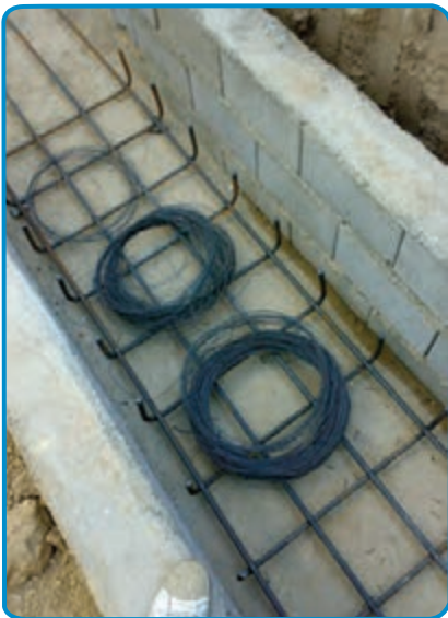
شکل ۹-۷- بهم بستن میلگردها
