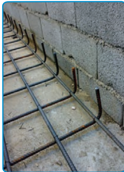
شکل ۱۰-۷- رعایت پوشش بتن در کف و بدنه
