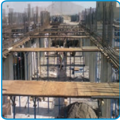
شکل ۷-۲۱- قالب بندی تیرها
