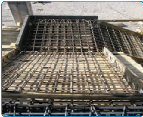
شکل ۳۷-۷- اجرای میلگردهای دال پله
