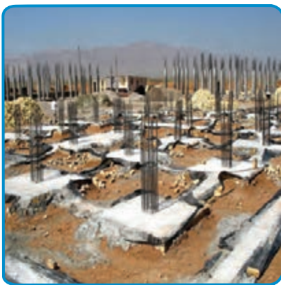
شکل ۱۷-۷- اجرای خاموت و سنجاقک
