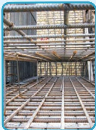
شکل ۱۵-۱- فولاد در بتن
