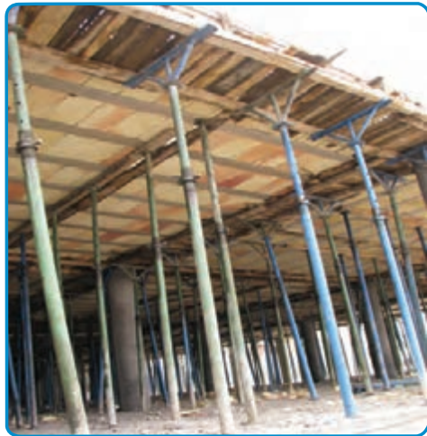
شکل ۳-۲۱- استفاده از شمع‌های فلزی جهت نگهداری قالب‌ها
