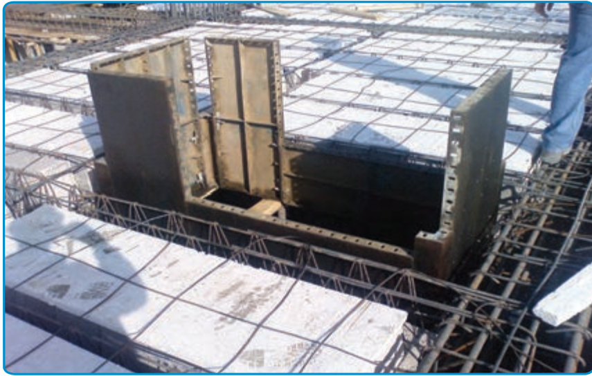
شکل ۳۵-۷- تکمیل قالب بندی
