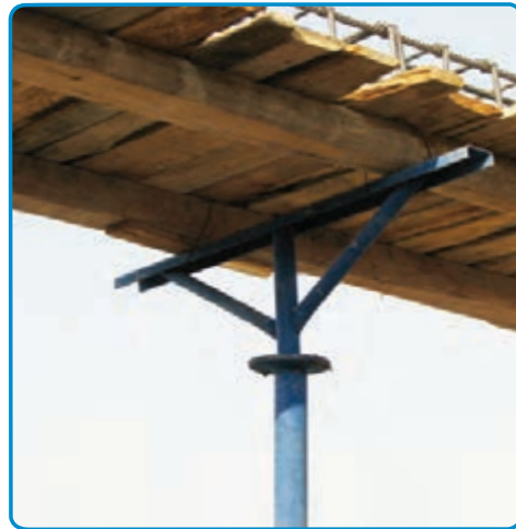
شکل ۳-۲۱- استفاده از شمع‌های فلزی جهت نگهداری قالب‌ها
