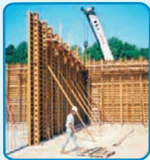
شکل ۱۹-۳- اجرای دیوار بتنی فایبر گلاس برای
