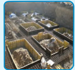
شکل ۳-۳۱- قالب فایبرگلاس برای اجرای پی
