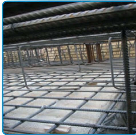
شکل ۳-۵۳- استفاده از خرک در میلگرد گذاری پی
