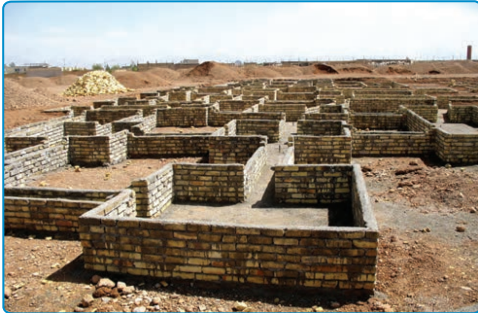
شکل ۱۵-۳- استفاده از قالب آجری برای اجرای پی
