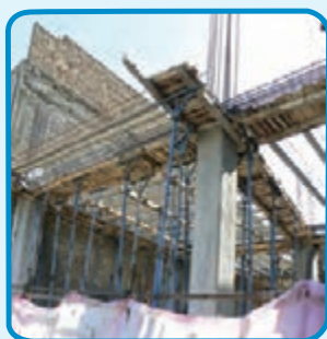
شکل ۳-۳۹- استفاده از قالب چوبی برای اجرای تیر
