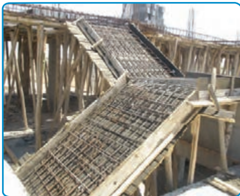
شکل ۳۹-۷- اجرای میلگردهای دال پله
