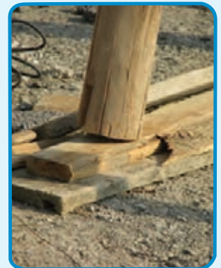
شکل ۳-۲۵- استفاده از گوه جهت تنظیم ارتفاع
