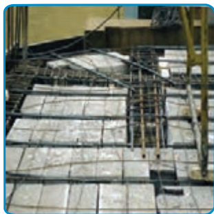
شکل ۷-۳۲- اجرای تیرهای فرعی کنسول
