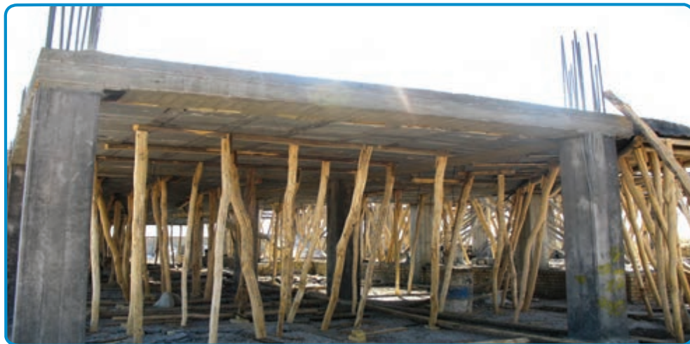
شکل ۳-۴۳- استفاده از پایه‌های اطمینان پس از قالب‌برداری سقف
