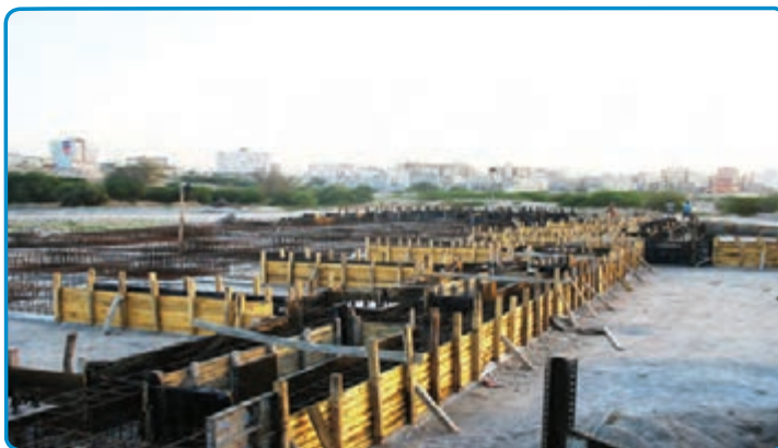
شکل ۳-۲۷- قالب چوبی برای اجرای پی
