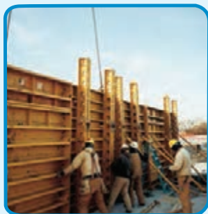
شکل ۳-۳۶- قالب فایبر گلاس برای اجرای دیوار بتنی
