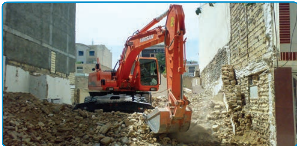
شکل ۳-۲- خاکبرداری با ماشین
