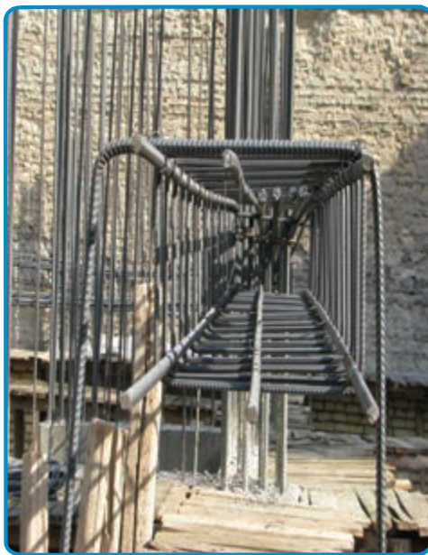
شکل ۳-۴۵- میلگرد طولی در تیر
