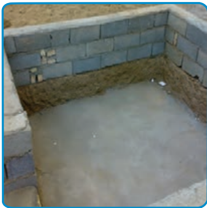
شکل ۱-۷- آماده سازی کف پی
