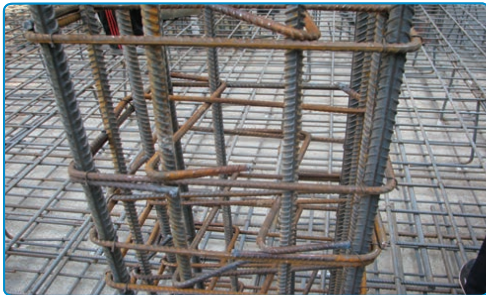
شکل ۵۰-۳- کاربرد سنجاقک در میلگرد گذاری ستون
