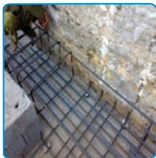
شکل ۱۲-۷- میلگردگذاری شبکه بالای
