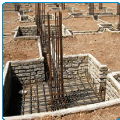
شکل ۴-۷- اجرای میلگردهای ریشه انتظار
