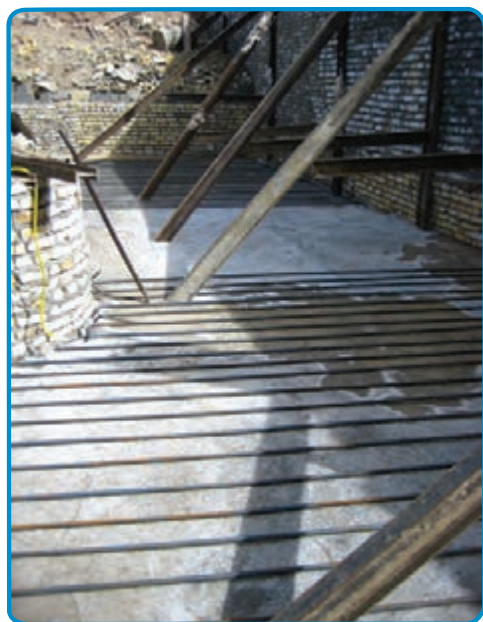
شکل ۳-۴۶- میلگرد طولی کف پی
