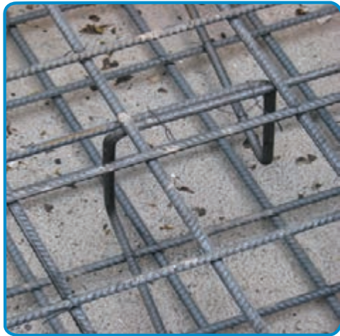
شکل ۳-۵۳- استفاده از خرک در میلگرد گذاری پی
