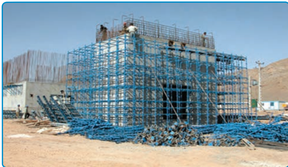
شکل ۳-۲۶- داربست فلزی
