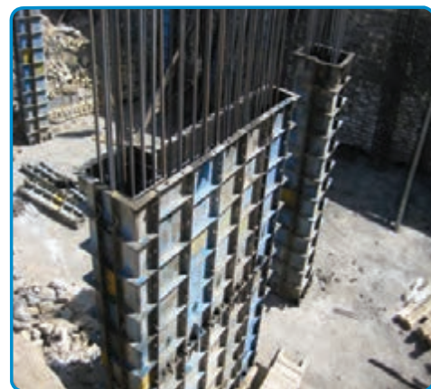
شکل ۳-۳۵- قالب فلزی برای اجرای دیوار بتنی
