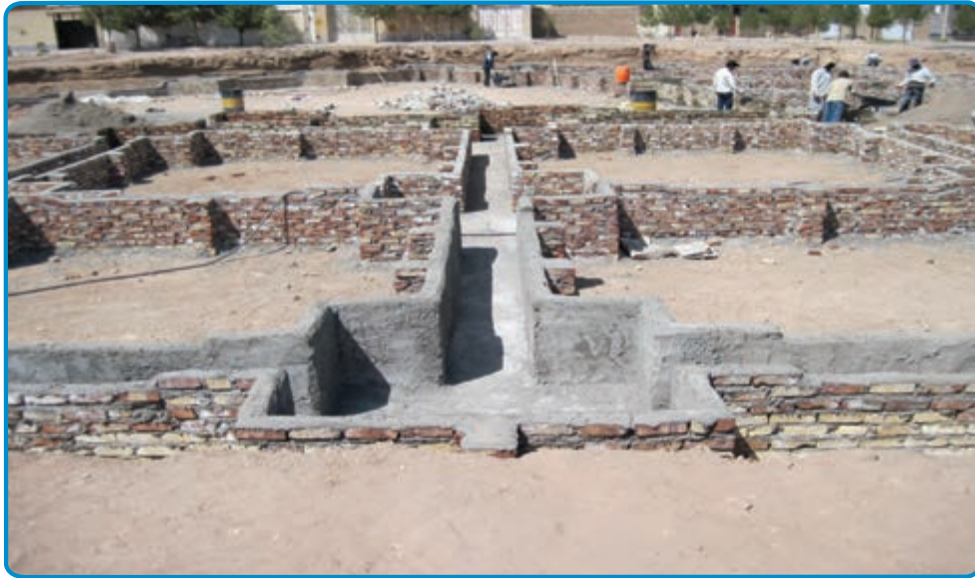
شکل ۳-۲۹- قالب آجری برای اجرای پی
