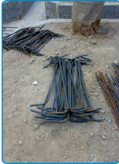
شکل ۷-۷- آماده کردن میلگردهای طولی و عرضی
