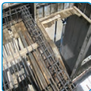
شکل ۷-۳۱- اجرای بازشودر سقف
