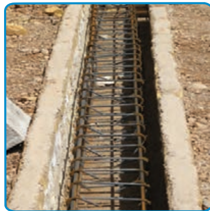
شکل ۵-۷- اجرای میلگرد شناژها
