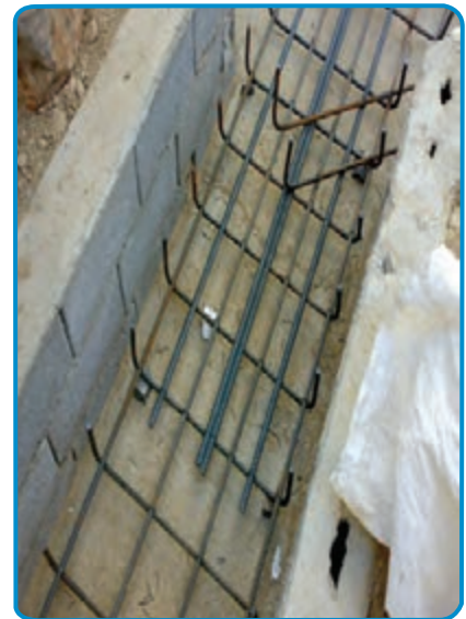
شکل ۱۱-۷- قرار دادن میلگردهای تقویتی
