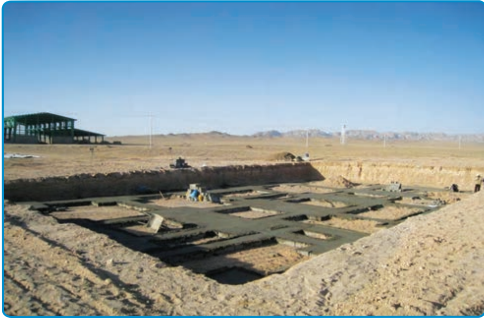
شکل ۳-۶- گودبرداری در زمین‌های نامحدود
