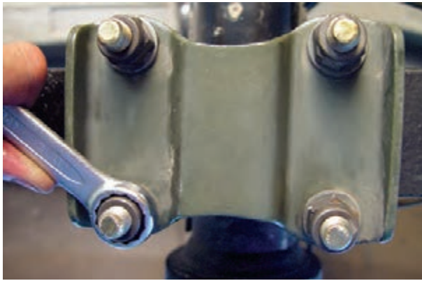
شکل ۳-۶۶- باز کردن مهره‌های کرپی‌ها (پیچ‌های U شکل)
