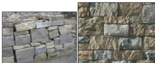
شکل ۱۴۵- سنگ بادبُر شکل ۱۴۶- سنگ بادبُر سرتراش
