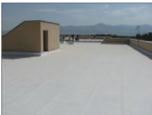
شکل ۱۲-۶ سطح پشت بام
