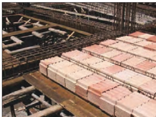
شکل ۱-۱۵۲ کاربرد بلوک سفالی در سقف
