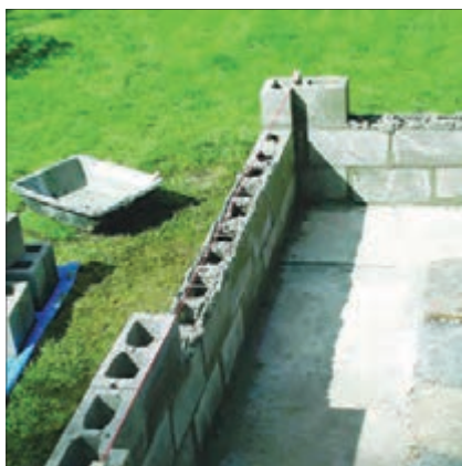
شکل ۱۵۰- ساخت دیوار با بلوک‌های بتنی یا سیمانی
