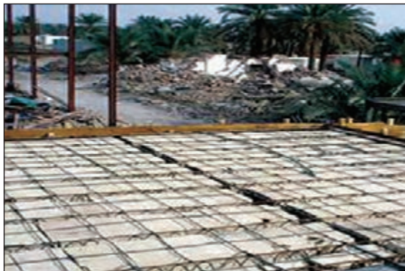
شکل ۱۳-۱ سقف تیرچه بلوک
