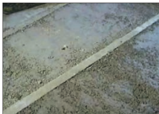
شکل ۲۱-۶ پرکردن فضای بین کرم‌ها با پوکه معدنی
