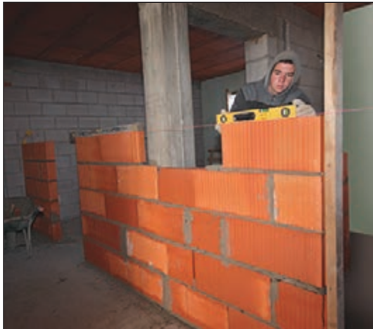
شکل ۱-۱۰۹ دیوار غیرباربر بلوک سفالی
