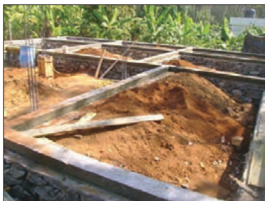
شکل ۲۰۵-۱ بتن ریزی کلاف بندی افقی تحتانی
