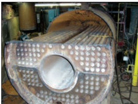
شکل ۴۲-۱ لوله‌ی چدنی دیگ بخار
