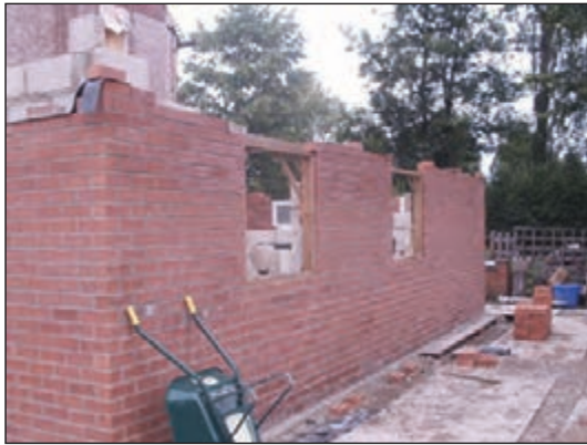
شکل ۱-۱۰۷ دیوار باربر آجری
