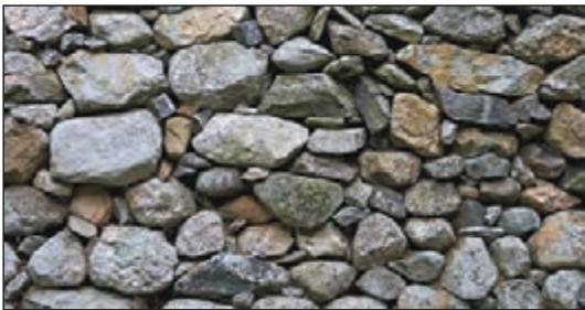
شکل ۱۳۶- دیوار سنگی خشکه چین
