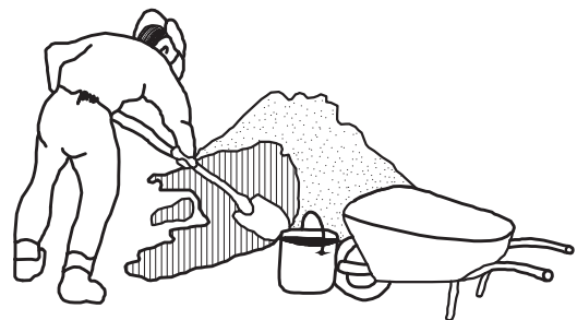
شکل ۱-۵۵ مخلوط خاک رس با آب و ساخت خمیر خشت
