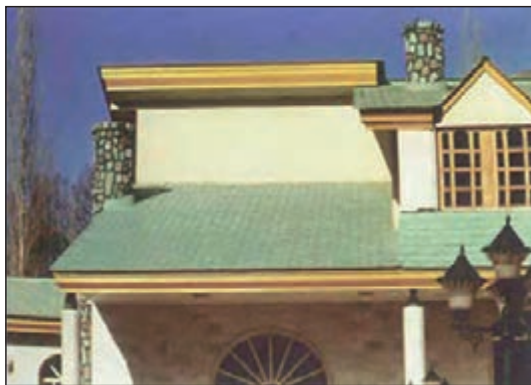
شکل ۱-۱۰۲ پوشش سقف با ورق‌های فشرده‌ی آردواز
