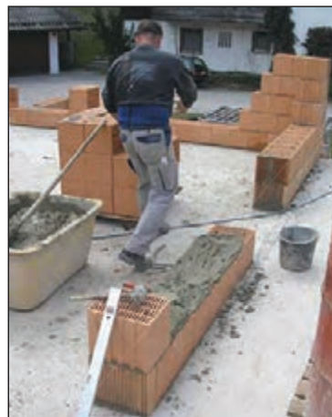
شکل ۱-۱۵۳ ساخت دیوار با بلوک سفالی
