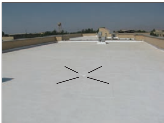
شکل ۱۱-۶ سطح پشت بام
