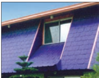
شکل ۴۷-۱ پوشش نهایی سقف شیب‌دار با آردواز
