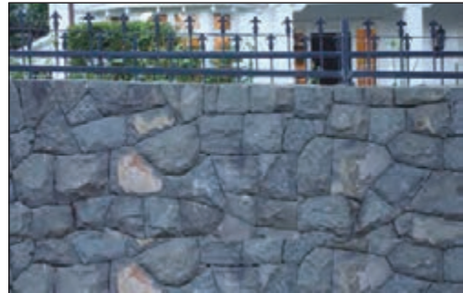
شکل ۱۹۶-۱ دیوار با سنگ کوهی چندوجهی نامنظم سرتراش بدون رج
