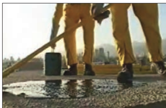
شکل ۲۲-۶ قیرگونی پس از پرکردن بین کُرْم‌ها
