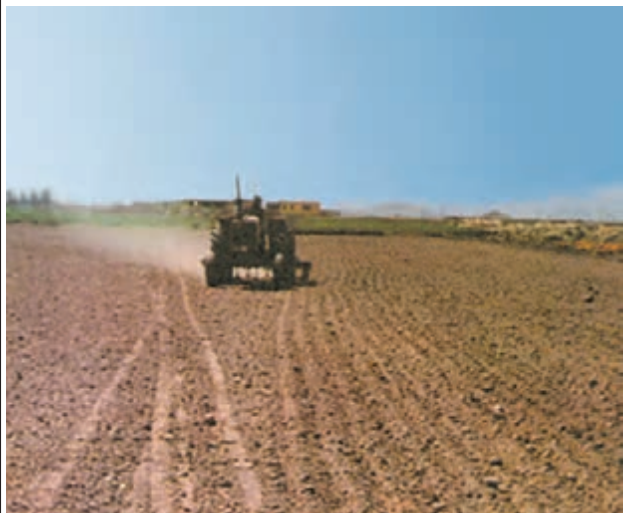
شکل ۸-۲- عملیات خرد کردن کلوخه‌ها به وسیله دیسک
