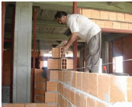
شکل ۱-۴- ریسمان کشی جهت اجرای مستقیم دیوار
