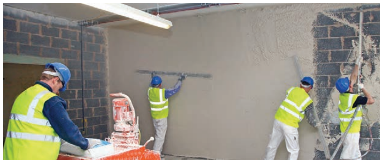
شکل ۱۷-۴- اندود گچ سفیدکاری روی دیوارهای داخلی
