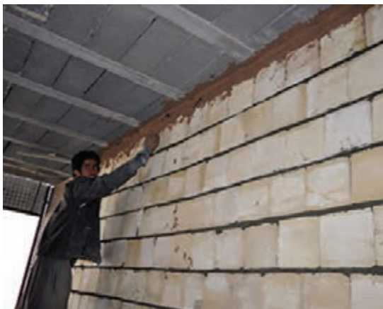
شکل ۲-۴- اجرای دیوار چینی با بلوک سفالی
