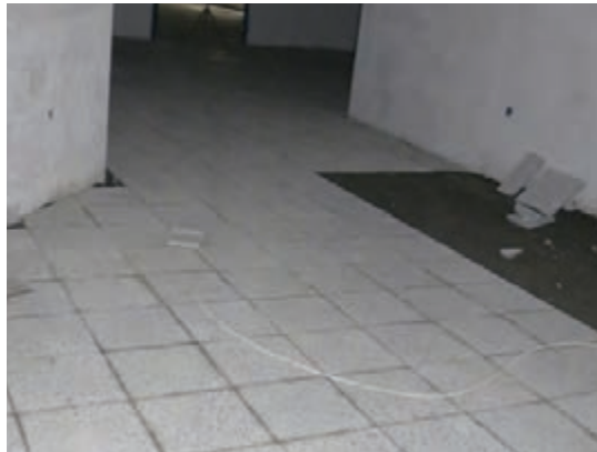
شکل ۲۷-۴- اجرای کف موزائیک در داخل ساختمان
