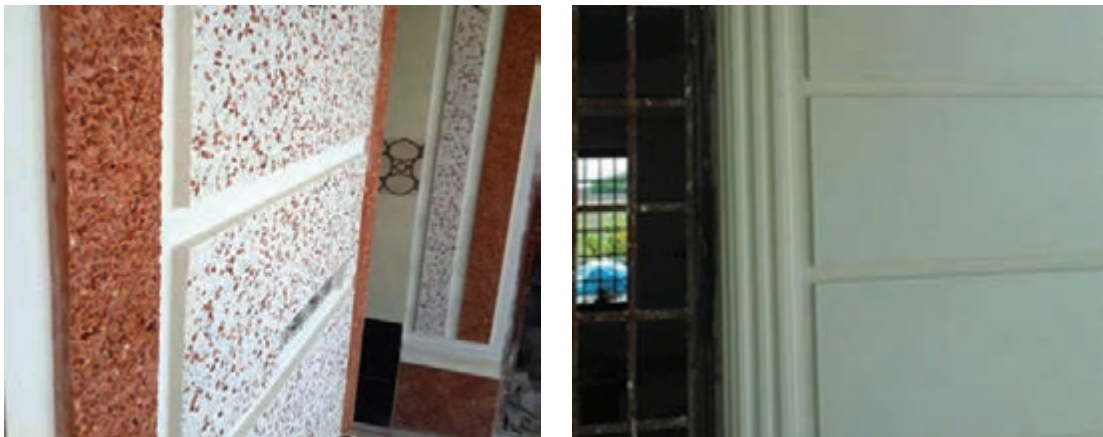
شکل ۲۰-۴- تزئینات اندود سیمان لیسه‌ای در نما شکل ۲۱-۴- اندود سیمان شسته موزائیکی در نمای داخلی
