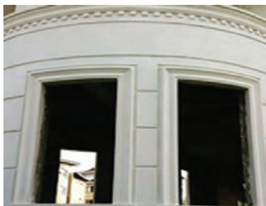
شکل ۱۹-۴- تزئینات بازشوها و چفت‌های نازک‌کاری با اندود سیمانی
