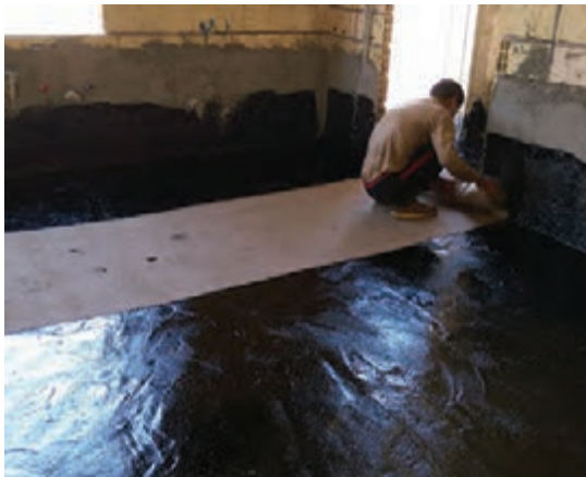
شکل ۱۱-۴- اجرای قیرگونی کف فضای داخلی
