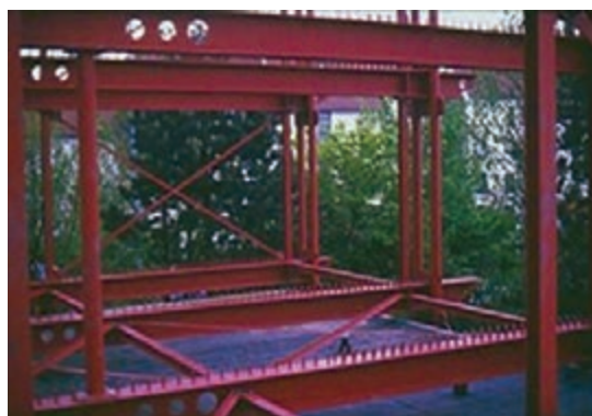
شکل ۹۷-۲- سازه‌ای مرکب از تیر و ستون و بادبند
