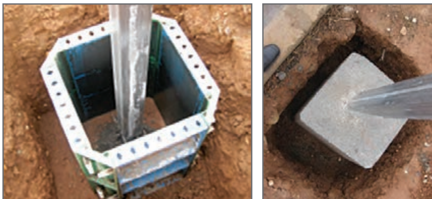
شکل ۸- فونداسیون سازه گلخانه
