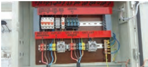
شکل ۶۴- نصب سرج ارستر
