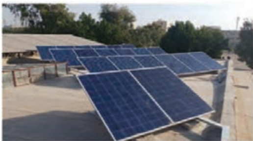
شکل ۲۴- نیروگاه برق خورشیدی نصب شده به ظرفیت ۳kw در هنرستان فنی و حرفه ای شهید بهشتی دزفول
