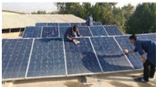
شکل ۴- تمیز کردن مدول‌های خورشیدی
