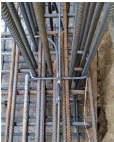
شکل ۲۲- جوشکاری میلگردهای شناژ با شالوده
