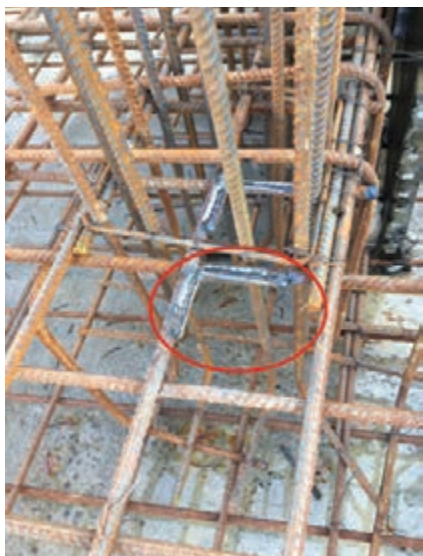
شکل ۱۹- جوشکاری میلگردها در یک تقاطع چهارراه
