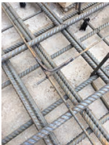
شکل ۲۱- جوش کاری میلگردها در تقاطع سه راهه
