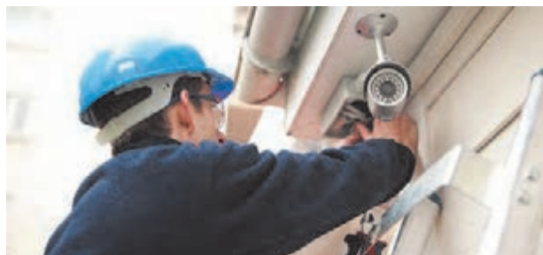
شکل ۲۹- نصب دوربین در فضای مناسب
