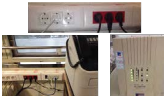
شکل ۱۶ - اتصال چند بار مختلف به UPS
