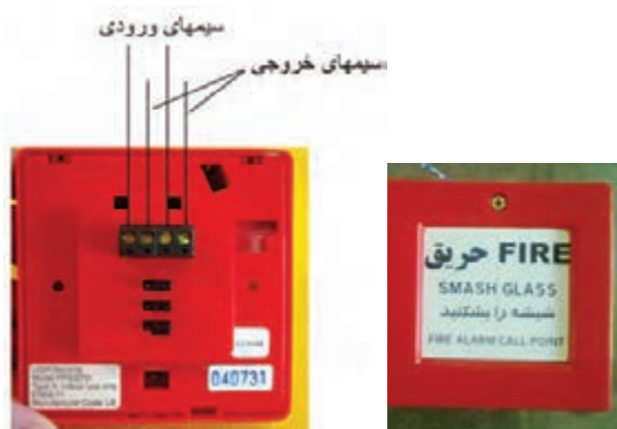
شکل ۱۰- شستی اعلام حریق با راهنمای فارسی
