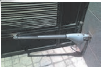
شکل ۲۲- جک موتوری
