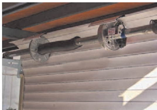
شکل ۱۱- محل نصب موتور کرکره‌ای
