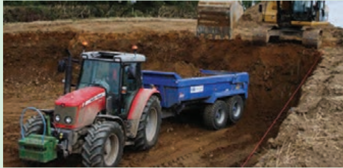
شکل ۱-۵۷- بارگیری نامناسب پی نورد
