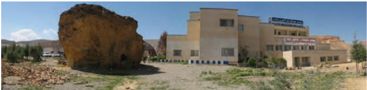
شکل ۵-۵- مجتمع آبگرم محلات
