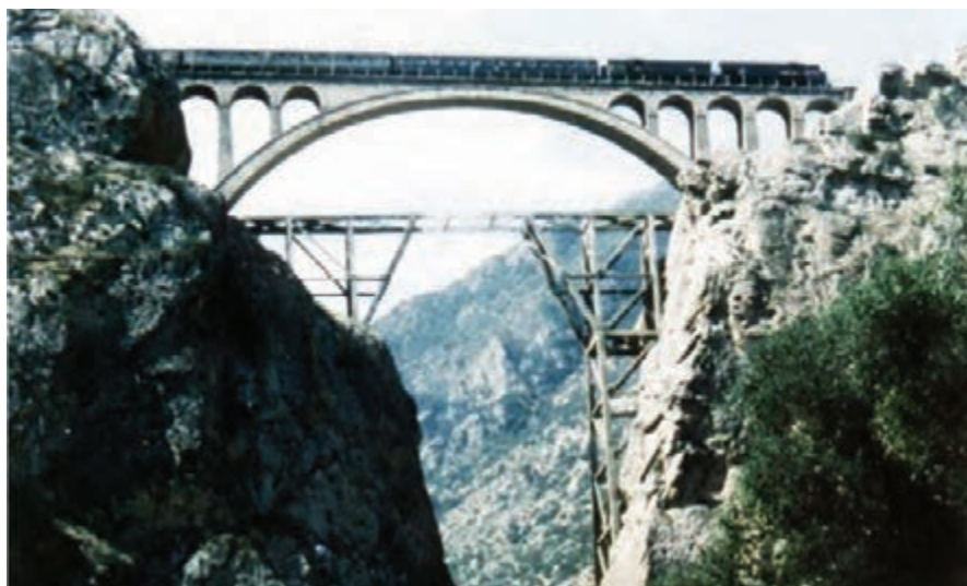
شکل ۲۸-۵- راه آهن شمال - پل ورسک
