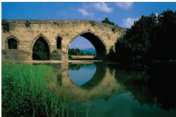
شکل ۲-۵- پل شاهپور در شیرگاه
