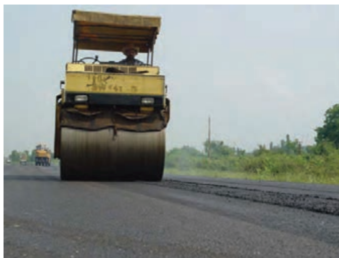
شکل ۴-۶- عملیات راه سازی
