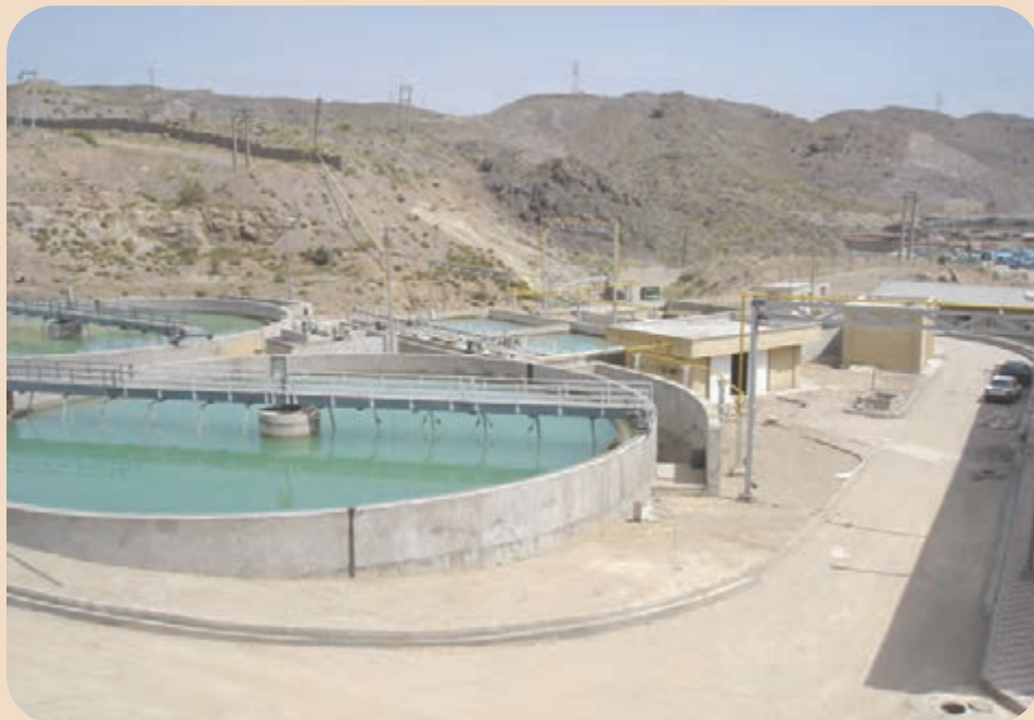
شکل ۱-۶۰- تصفیه خانه مجتمع مس سرچشمه
