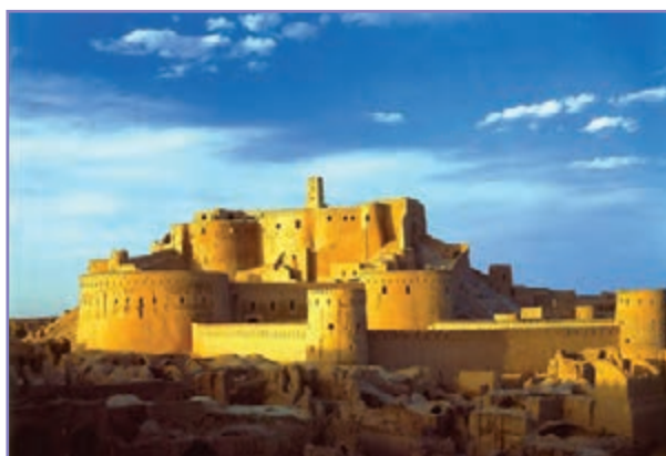
شکل ۳۰-۵- ارگ بم قبل از زلزله
