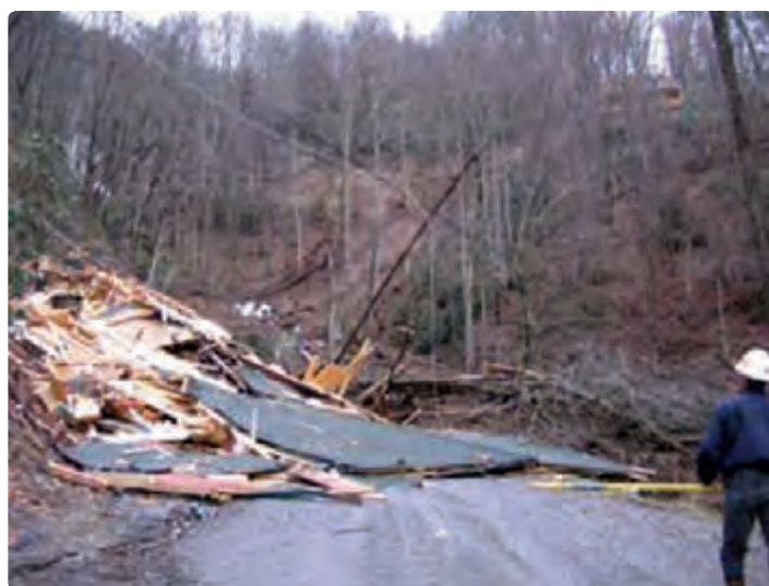
شکل ۱۲-۱- تخریب ناشی از رانش زمین
