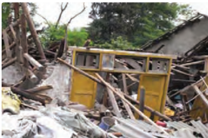
شکل ۱۱-۱- عدم رعایت شرایط مناسب خانه‌سازی، عامل اصلی خسارات ناشی از زمین‌لرزه است.
