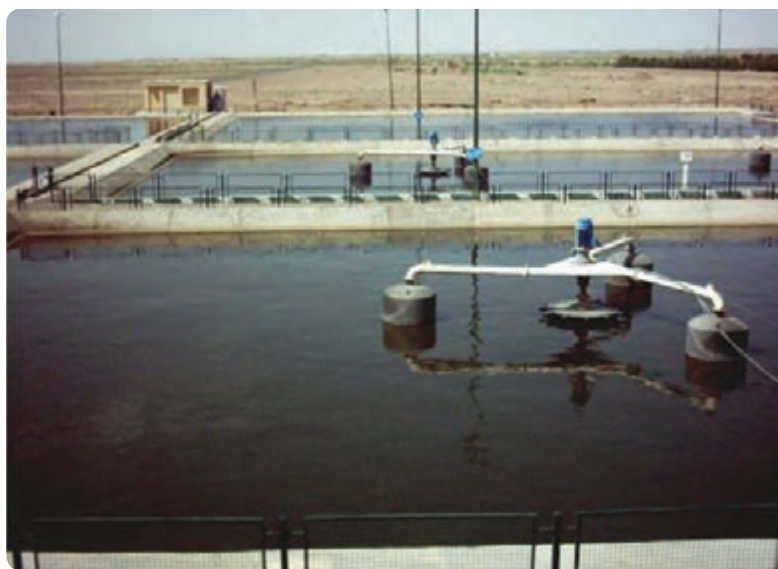
شکل ۴۹-۱. یکی از تصفیه‌خانه‌های فاضلاب شهرک‌های صنعتی استان
