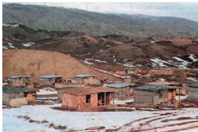
شکل ۱-۶۴- بازسازی روستای زده زلزله زده توپ چنار شهرستان مانه و سملقان با استفاده از اسکلت زوگالی (چوبی)
