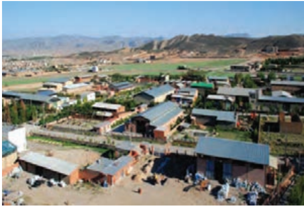
شکل ۱۶-۶- شهرک صنعتی و بستر سازی برای ایجاد اشتغال
