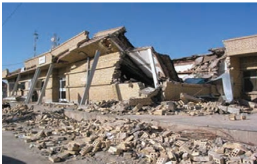
شکل ۱۲-۲- خسارات ناشی از زلزله در استان
