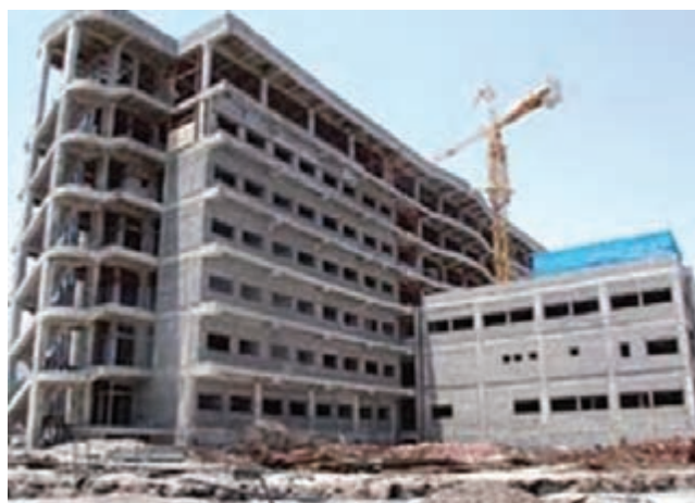
شکل ۱۰-۱۴- عملیات ساخت بیمارستان ۲۰۰ تختخوابی امام رضا(ع)
