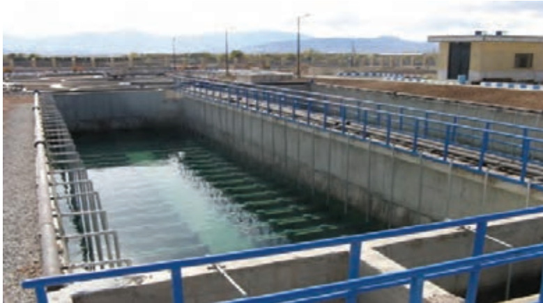
تصویر ۱-۵- تصفیه خانه شهرک صنعتی شهرکرد
