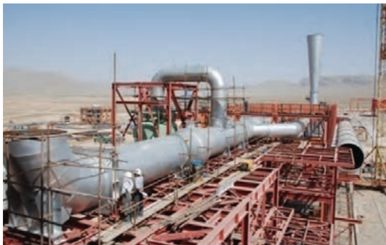
تصویر ۱-۱۵- کارخانه درحال احداث فولاد چهارمحال
