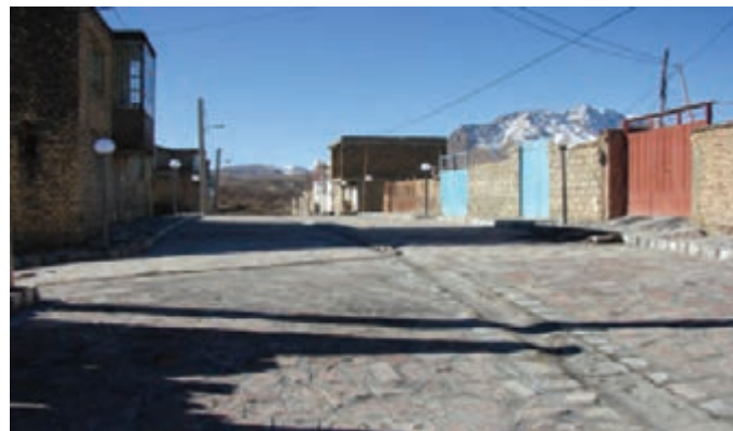
تصویر ۱-۱۴- اجرای طرح‌های روستایی
