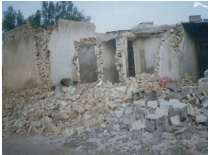
شکل ۲-۵- زلزله منطقه باغان (دشتی)
