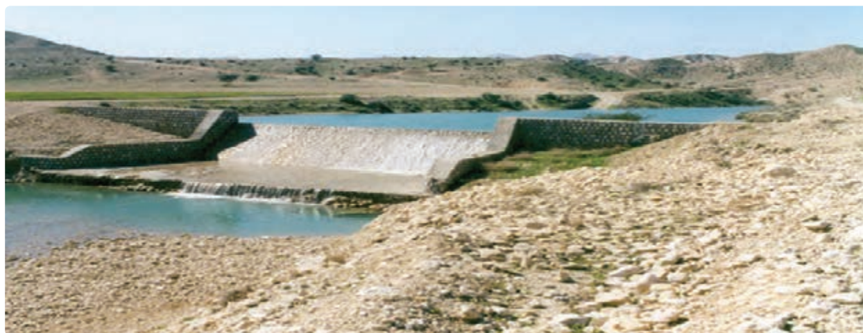
شکل ۱۳-۱۴- احداث استخرهای ذخیره آب
