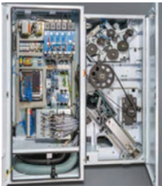
شکل ۳۷- انتقال حرکت و تابلوی برق در ماشین شانه
